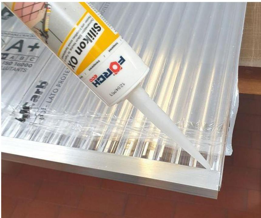
**Schritt 4:** Die Oberkante des Kantenschutz mit einer dünnen Silikonnaht verschließen
