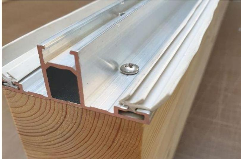
**Schritt 1: bei Schraubprofilen:** Profil auf Sparren auflegen und mit einer kleinen Schraube befestigen
